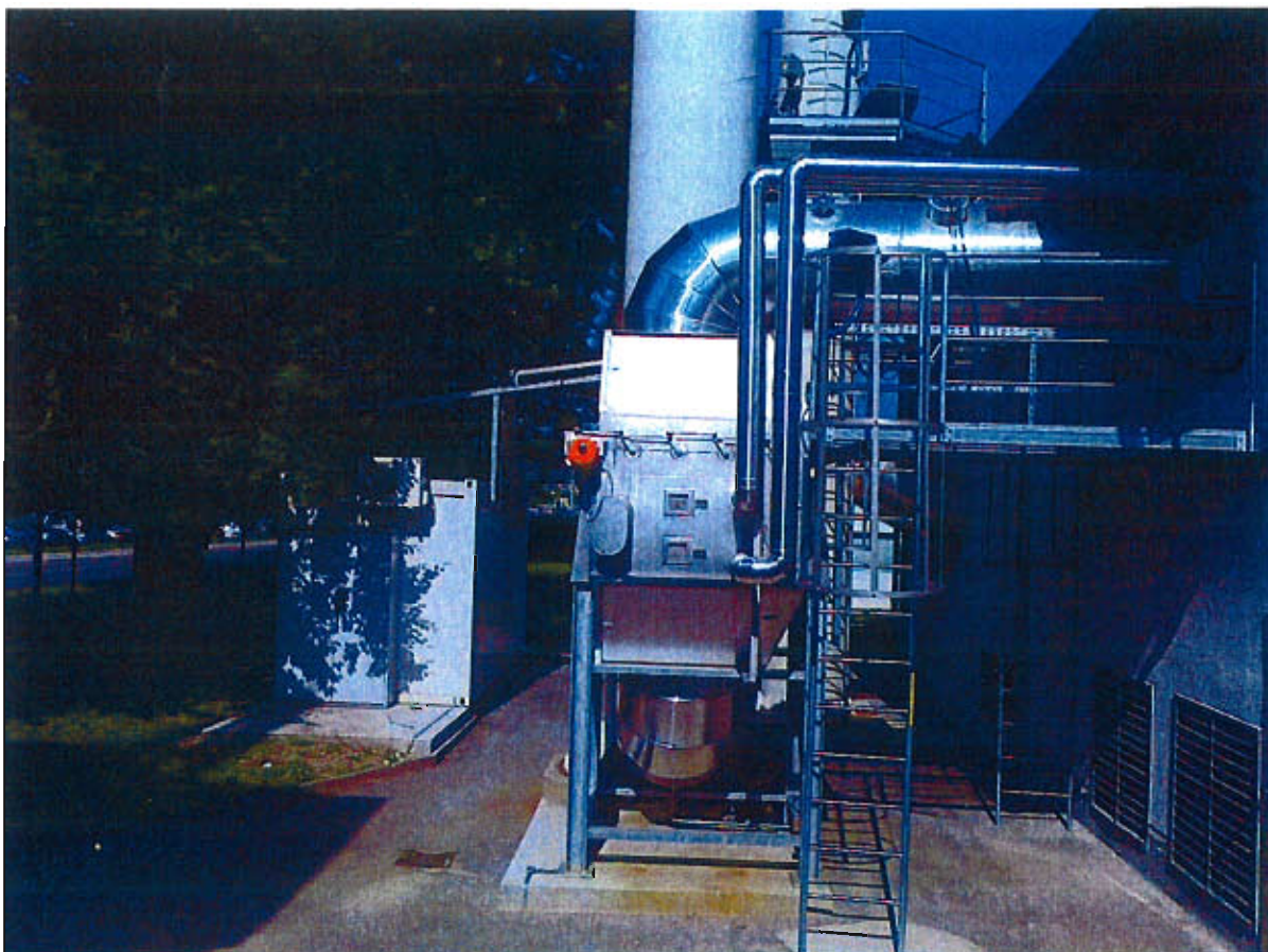
Slika 4: Fotografija lokacije merilnega mesta ZMM44 na izpustu Z44 kurilne naprave VISSMANN VITOMAX 300HS (naprava z oznako N13a)
