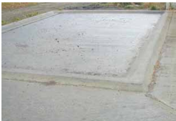
Slika 14 in 15: Posebno mesto čiščenja in polnjenja škropilnic, ki je betonirano. Kontaminirane odpadne tekočine so speljane v biopurifikacijski sistem preko rešetk (desno) ali betoniranega žleba (levo)(vir: ADAS).
