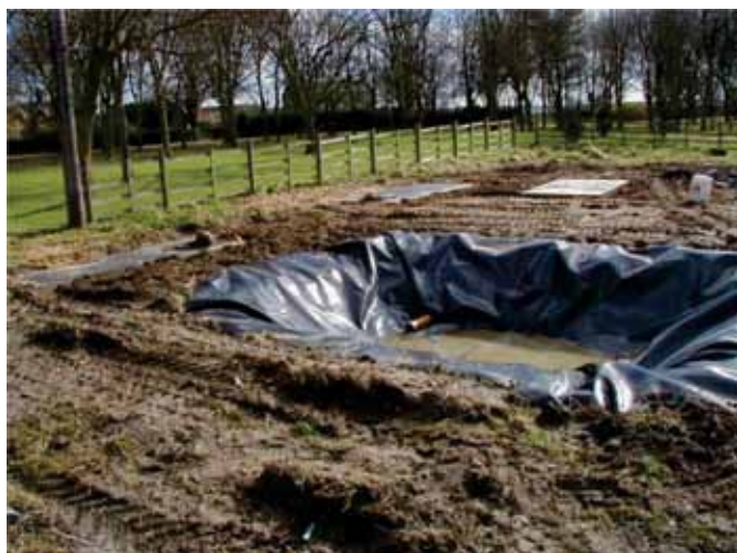
Slika 23on 24: Alternativa za beton , Biobef je lahko zatesnjen tudi z plastčno folijo kot EPDM (levo, vir ADAS) in PE vsebniki (desno, vir Mybatec).
