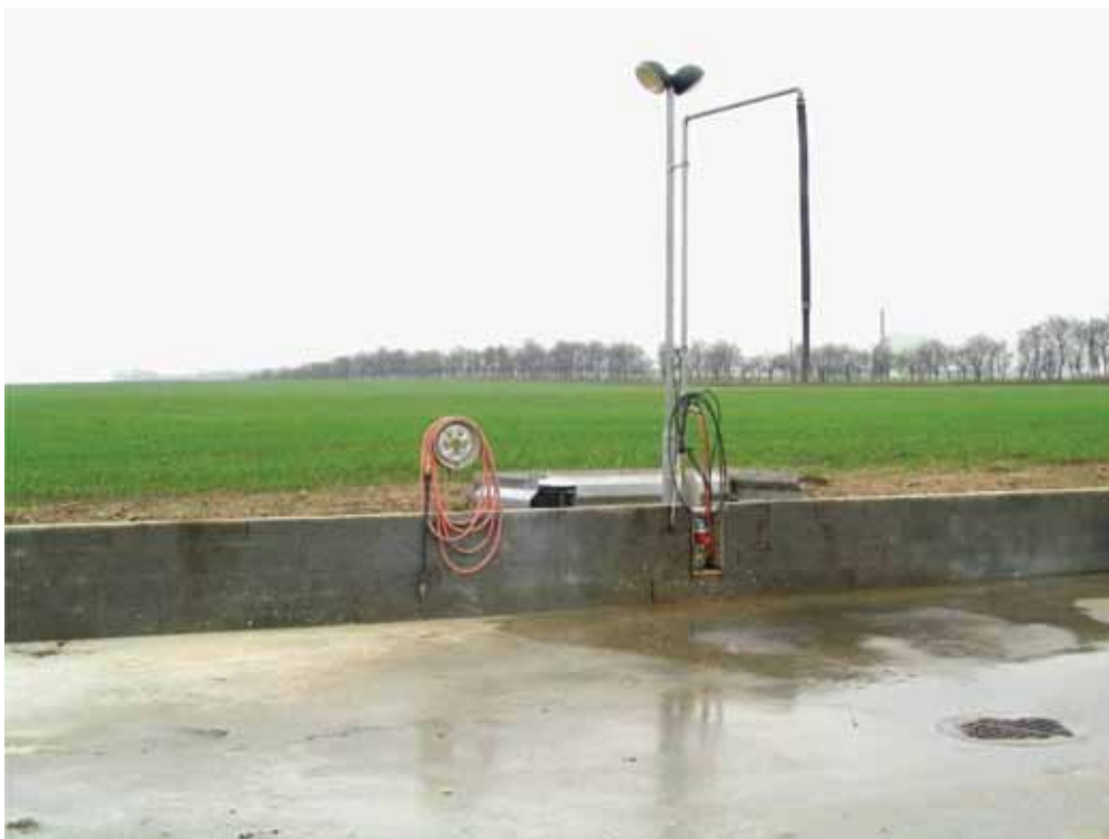
Slika 13: Ločeno mesto polnjenja in čiščenja s pripomočki za čiščenje, odpadne kontaminirane tekočine so speljane v biopurifikacijski sistem (Vir: DAAS)
