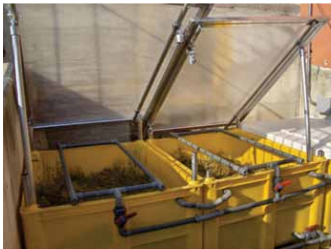
Slika 23on 24: Alternativa za beton , Biobef je lahko zatesnjen tudi z plastčno folijo kot EPDM (levo, vir ADAS) in PE vsebniki (desno, vir Mybatec).
