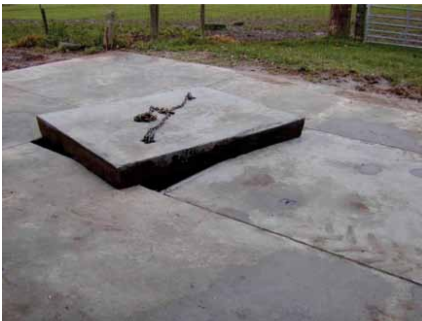
Sliki 16 in 17: primer 4000 l PE vmesnega rezervoarja in podzemnega betoniranega vmesnega rezervoarja velikosti 5000 l v bližini mesta polnjenja in čiščenja škropilnic – s posebnim ločevalnim ventilom za deževnico (vir:pcfriut).
