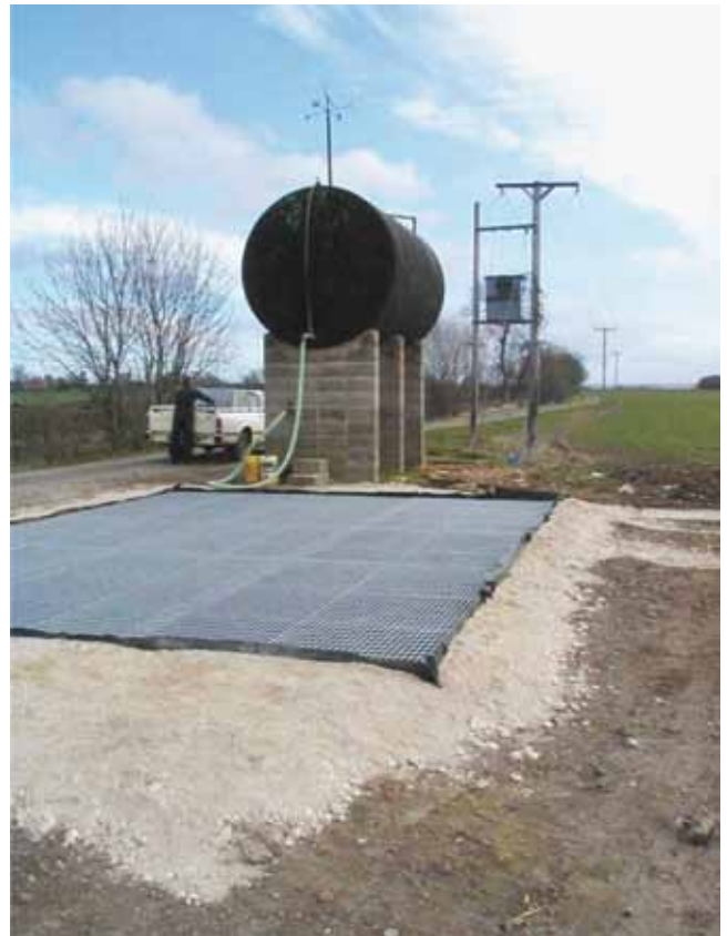
Slika 9: Tračnice preko Biobeda (vir: Visavi) Slika 10 : Vožnja preko rešetke na Biobedu
