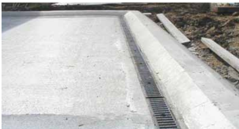
Slika 14 in 15: Posebno mesto čiščenja in polnjenja škropilnic, ki je betonirano. Kontaminirane odpadne tekočine so speljane v biopurifikacijski sistem preko rešetk (desno) ali betoniranega žleba (levo)(vir: ADAS).
