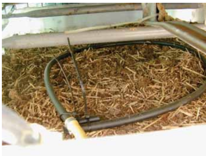
Slika 19 in 20: Porazdelitev kontaminirane tekočine po površini s pomicjo kovinske plošče (levo, vir Craw) ali z zaokroženo preluknjano cevjo (desno, vir pcfriut).
