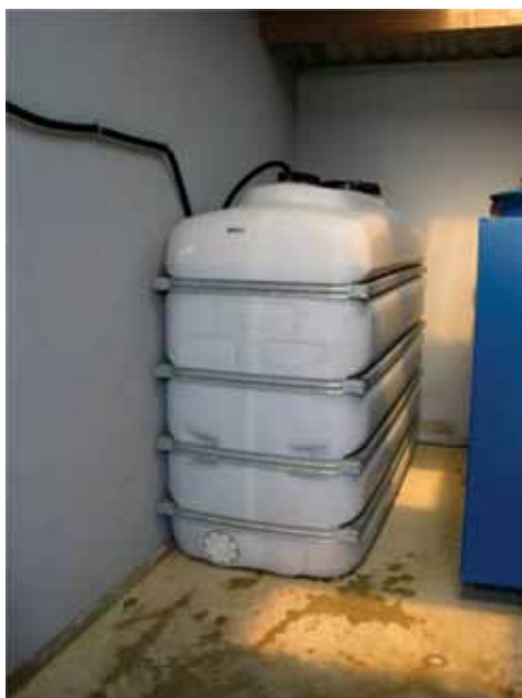
Sliki 16 in 17: primer 4000 l PE vmesnega rezervoarja in podzemnega betoniranega vmesnega rezervoarja velikosti 5000 l v bližini mesta polnjenja in čiščenja škropilnic – s posebnim ločevalnim ventilom za deževnico (vir:pcfriut).
