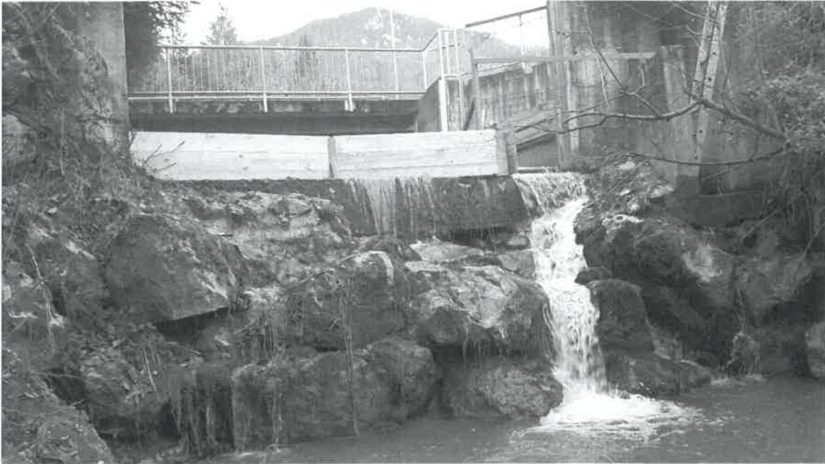
Okroglo jez pri zajetju 2,1m Photo 5 - dam at the inlet (2,10m)
