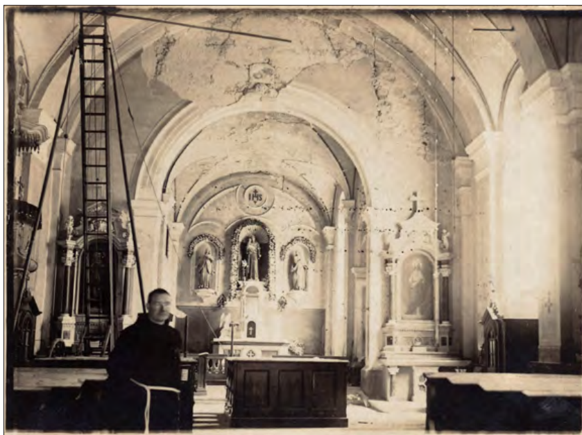
Slika 1. Poškodovana notranjost frančiškanske cerkve sv. Antona Padovanskega v Brežicah (slika hrani PMB).
