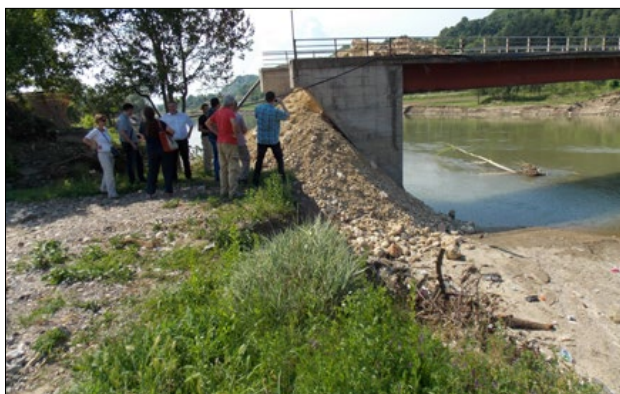
Slika 10: Porušen most čez reko Bosno v Doboju - Kostanjici (foto: M. Kobold)
