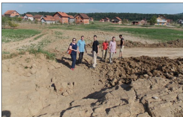
Slika 12: Ogled sanacije nasipa pri Modriči (foto: M. Kobold)
