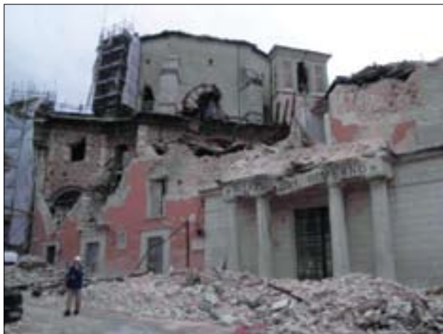
Slika 4. Potres v mestu L'Acquila aprila 2009 je hudo poškodoval tudi poslopje prefektore (foto: arhiv P. Weiss)
