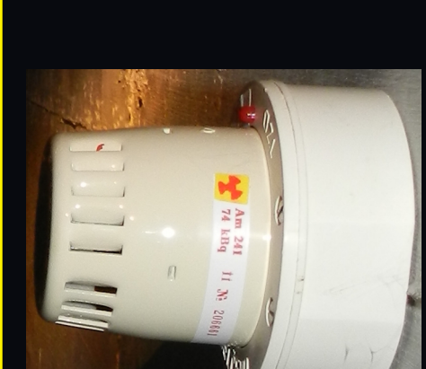
Radioaktivni strelovod
