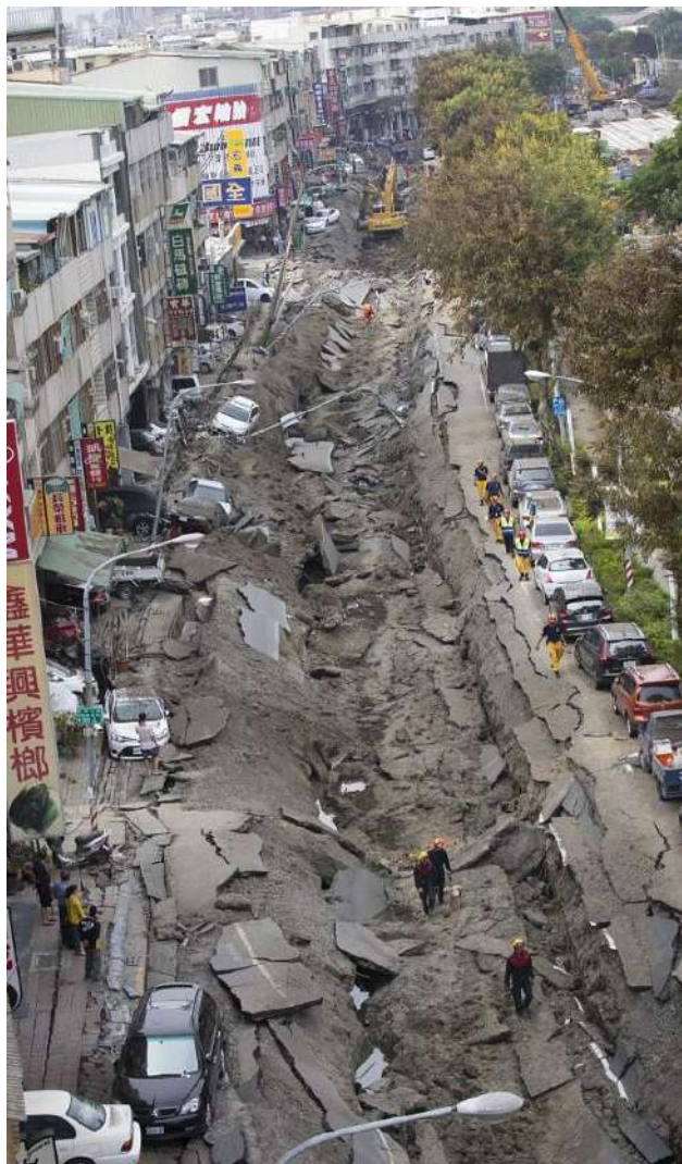
Slika 16: Eksplozija kanalizacijskega sistema zaradi puġljanja zemeljskega plina vanj (Tajvan 2014).
