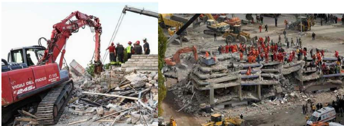
Slika 8: Rovokopaġ z drobilnimi kleġġ ami in avtodvigalo pri odstranjevanju potresnih ruġevin (L'Aquila) i' levo, slika deloviġġ a (Turġ ija) - desno.
