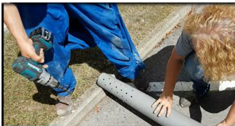
Slika 20: navrtanje konca zbiralne cevi.
