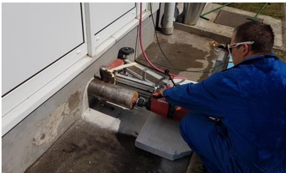
Slika 17: vrtanje s kronske vrtalnimi strojem.
