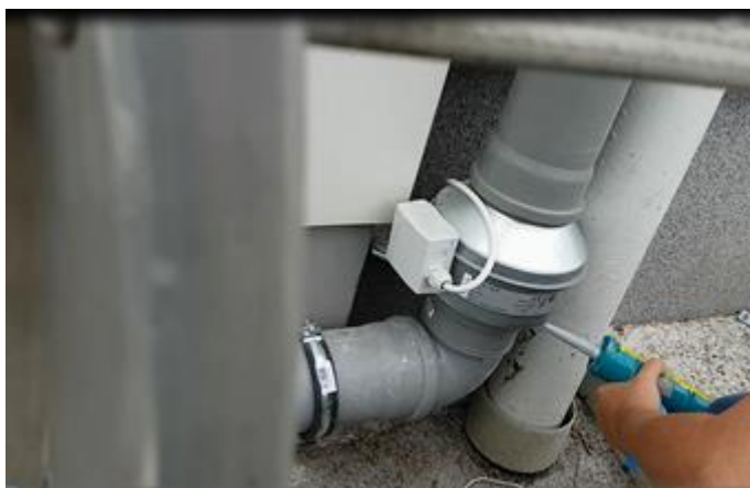
Slika 26: montaža in tesnjenje ventilatorja.
