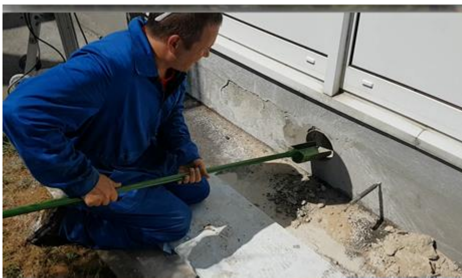
Slika 18: izkop kaverne s posebno lopato.
