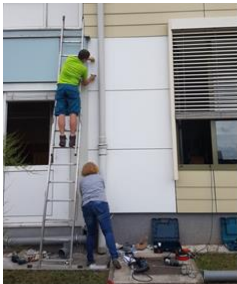
Slika 24: montaža razvoda na zid.
