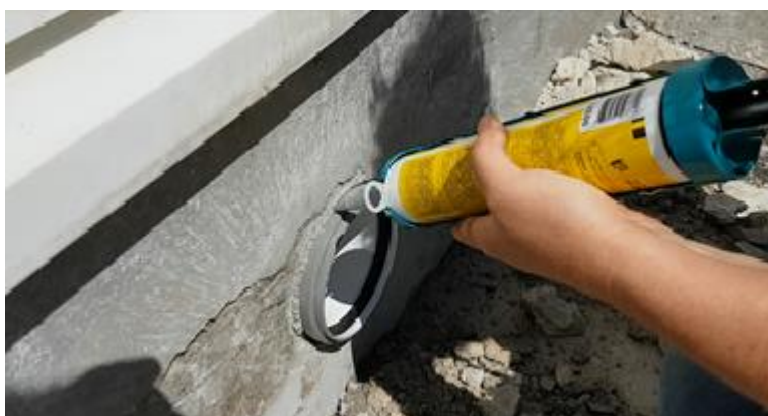
Slika 23: tesnjenje cevi in zidu.
