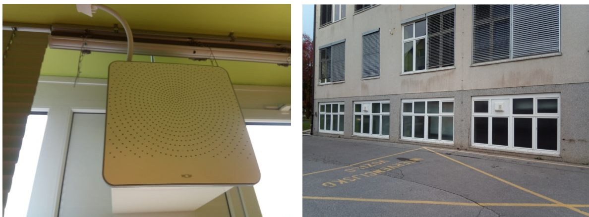
Slika 96. Vgrajen ventilator v učilnicah U01 in U02
