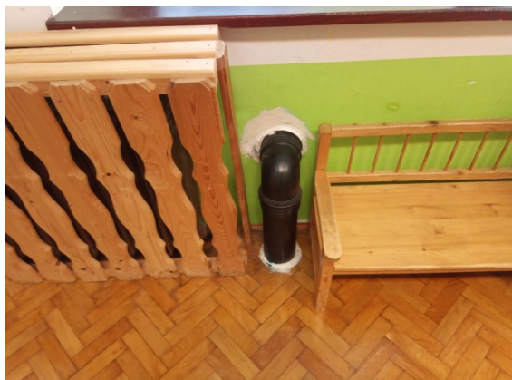
Slika 94. Izvedba sanacije, cev v prostoru in izpuh na prostem
