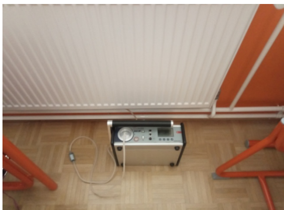
Slika 64. Telovadnica, špranja levo pod oknom
