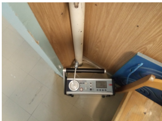
Slika 11. Hodnik, špranja ob cevi za hidrant
