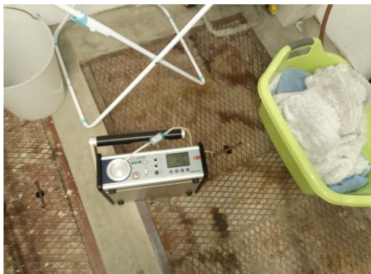
Slika 16. Kotlovnica, jašek v tleh
