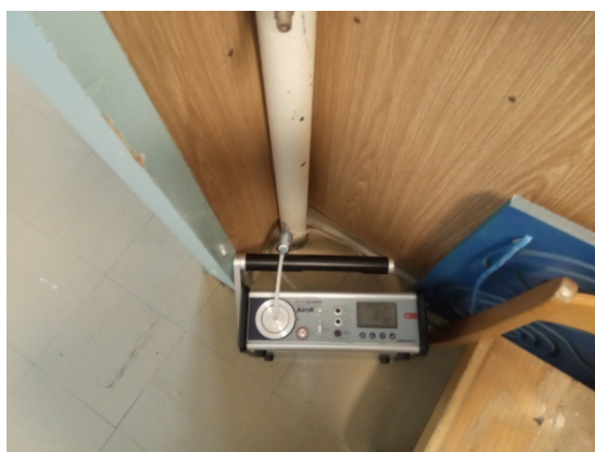
Slika 13. Kotlovnica, sifon v tleh
