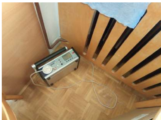
Slika 118. Špranja pod oknom
