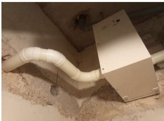
Slika 50. Izvedba sanacije z ventilatorjem
