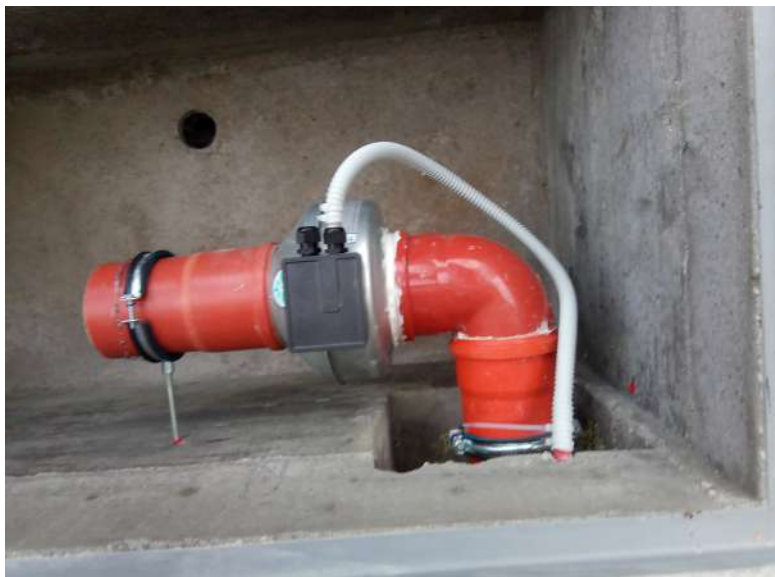
Slika 22. Sanacija učilnice 1. razred, izpuh z ventilatorjem
