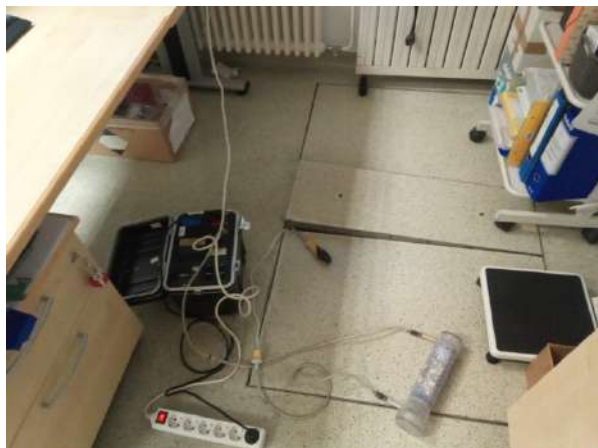
Slika 132. Jašek pod oknom
