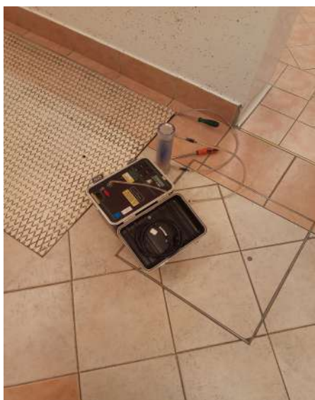
Slika 84. Garderoba, jašek za kanalizacijo
