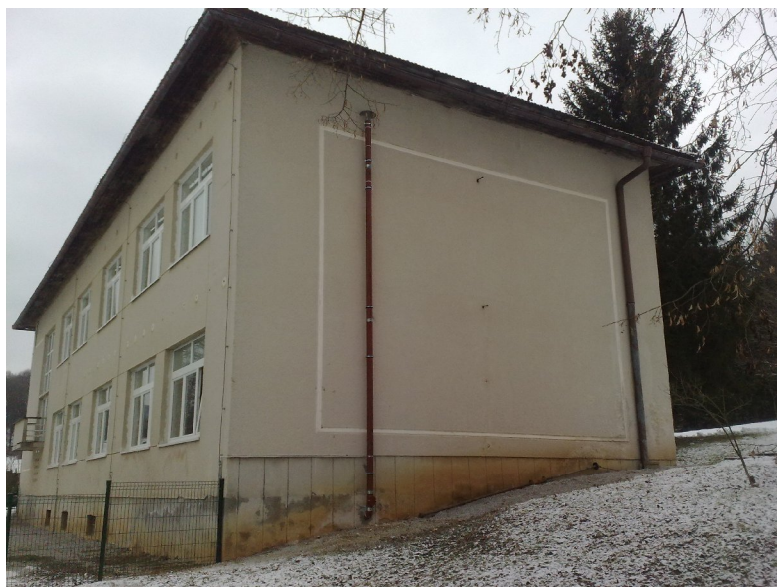
Slika 15. Izvedba sanacije vrtca Muljava
