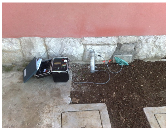
Slika 9. Izpuh izpod temeljne plošče
