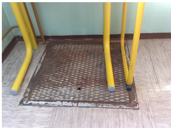
Slika 12. Kanal za centralno napeljavo
