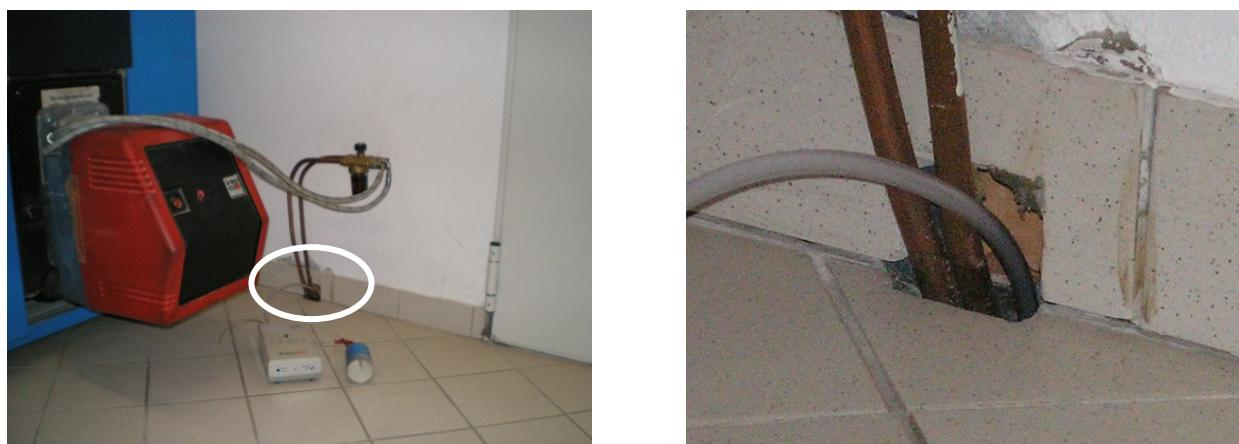
Slika 32: Odvzem vzorca zraka iz voda-jaška za centralno kurjavo v kleti v Osnovni šolo in vtrcu v Godoviču
