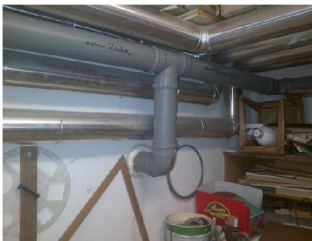
Slika 6. Odvod zraka izpod temeljne ploš e
