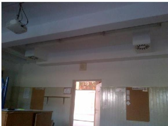
Slika 19. Sistem za prezraevanje – odvod zraka
