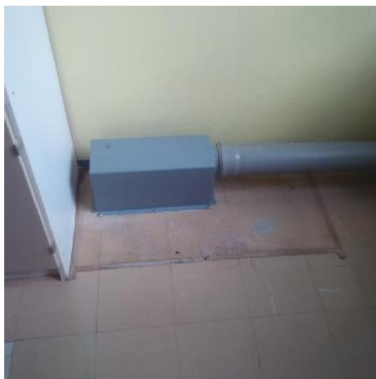
Slika 29. Odvodna cev izpod temeljne ploše
