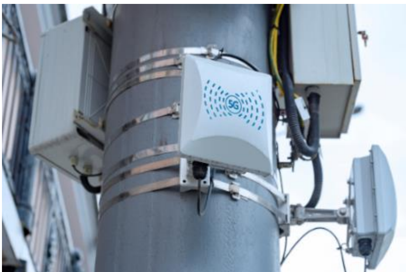
S 6: Primer namestitve anten majhne celice 5G na drogu javne razsvetljave.
