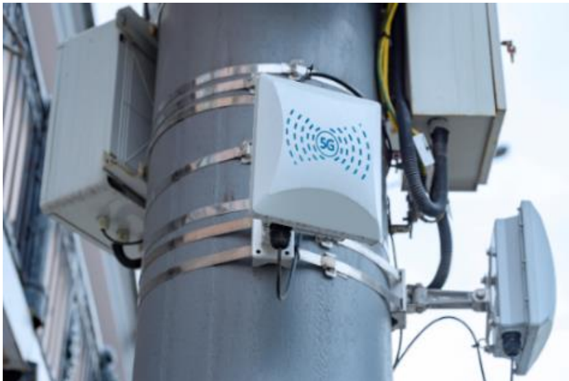
S 9: Primer namestitve anten majhne celice 5G na drogu javne razsvetljave.
