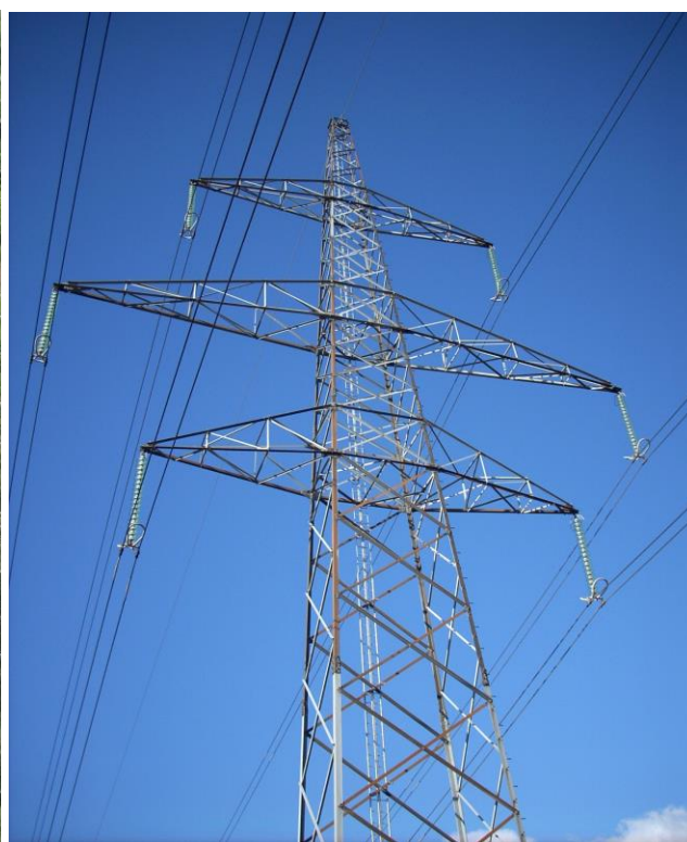
S 4: Najpogostejši tip stebrov dvosistemskega daljnovoda: sod.
