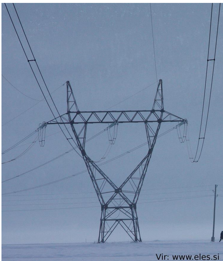
S 3: Najpogostejša tipa stebrov enosistemskega daljnovoda. Levo jelka, desno Y.
