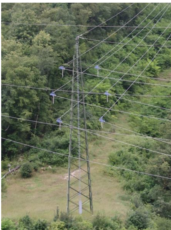
S 4: Najpogostejši tip stebrov dvosistemskega daljnovoda: sod.
