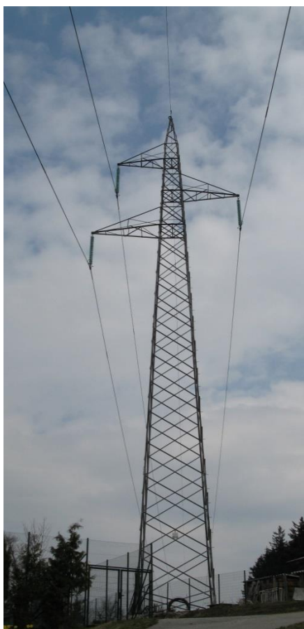
S 3: Najpogostejša tipa stebrov enosistemskega daljnovoda. Levo jelka, desno Y.
