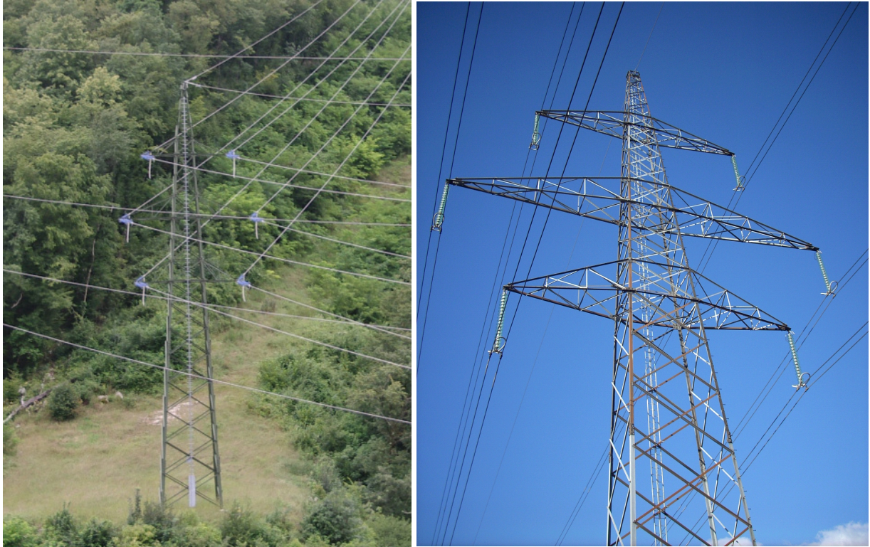
S 4: Najpogostejši tip stebrov dvosistemskega daljnovođa: sod.
