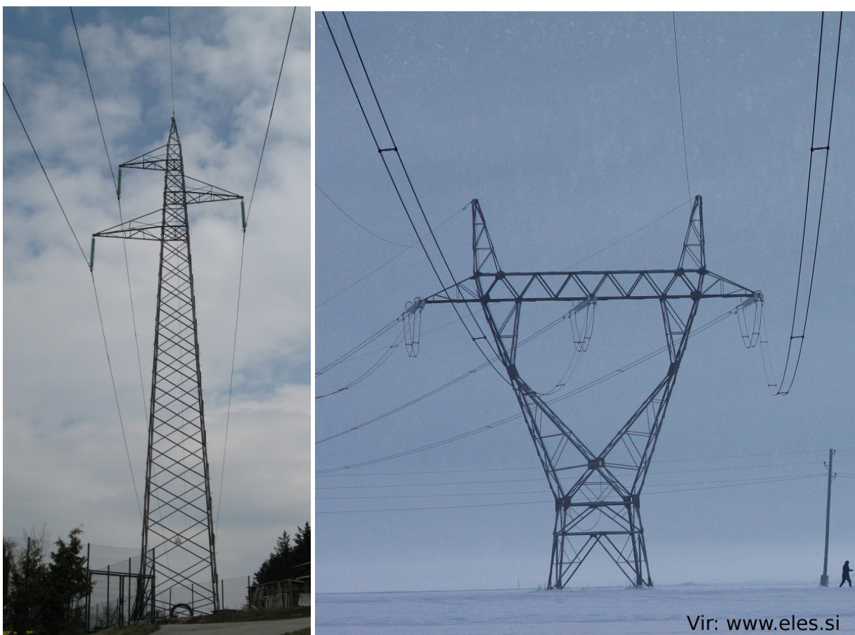
S 3: Najpogostejša tipa stebrov enosistemskega daljnovoda. Levo smreka, desno Y.
