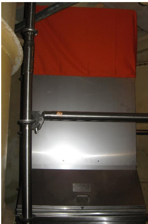
Slika 73: Avtokatalitični rekombajner (PAR) (Foto: inšpekcija URSJV)
