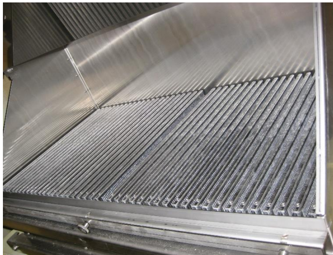
Slika 73: Avtokatalitični rekombajner (PAR) (Foto: inšpekcija URSJV)
