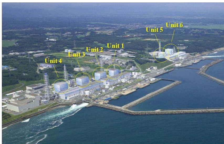
Slika 19: Jedrska elektrarna Fukušima I (enote 1-6) pred potresom
