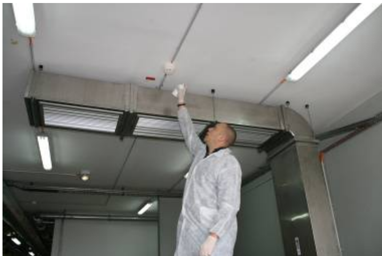
Slika 12: Funkcionalni preizkus delovanja javljalnikov požara v CSRAO
