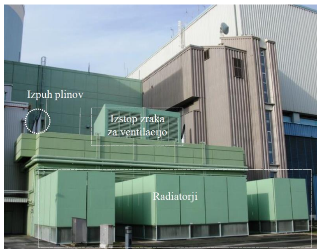
Slika 14: Štirje radiatorji, prek katerih se odvaja toplota iz dizelskega generatorja št. 1 in dizelskega generatorja št. 2.
