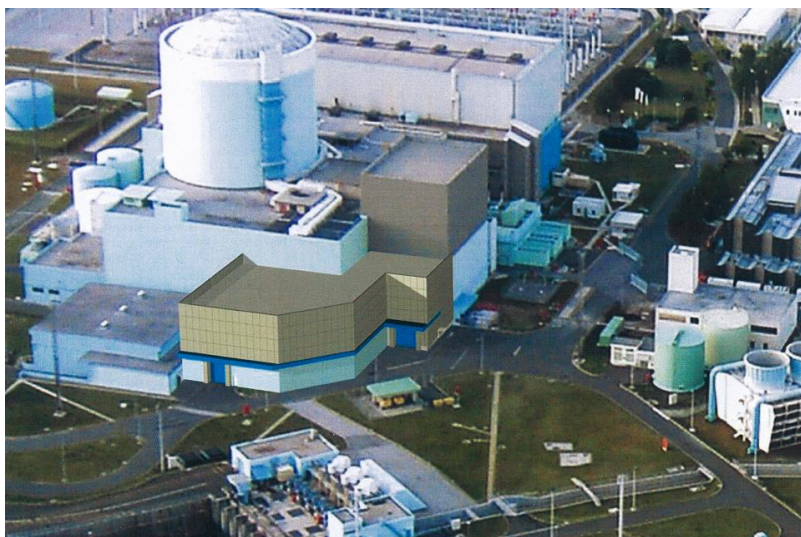
Slika 51: Lokacija bodočega prostora za manipulacijo z opremo in pošiljkami radioaktivnih tovorov (WMB)
