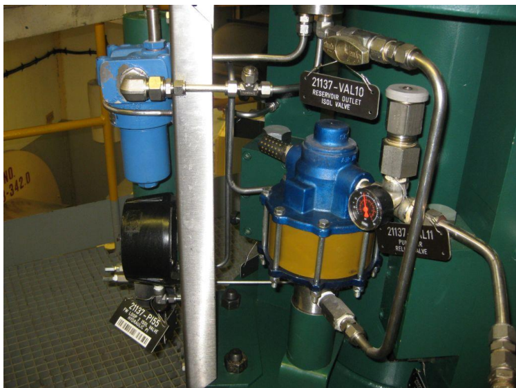
Slika 68: Rezervoar hidravličnega olja izolacijskega ventila napajalne vode (Foto: inšpekcija URSJV)
