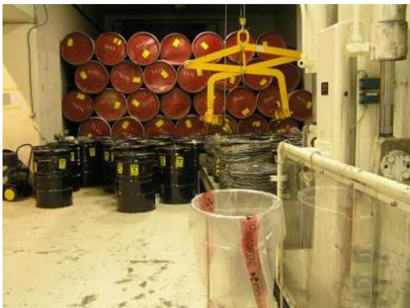
Slika 47: Skladišče nizko in srednje radioaktivnih odpadkov v NEK: superkompaktiranje sodov
