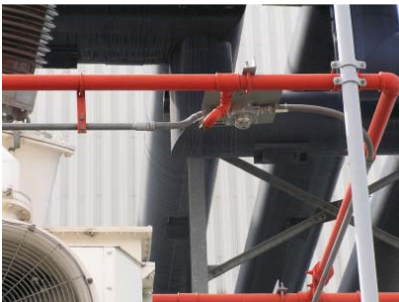
Slika 49: Toplotni detektor in pršilna šoba (sprinkler) protipožarne zaščite glavnega transformatorja v NEK
