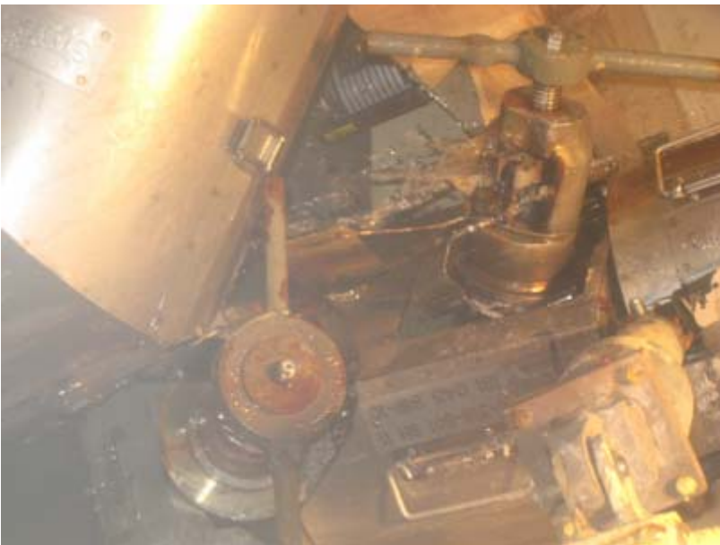
Slika 51: Puščanje na izolacijskem ventilu na liniji za meritev temperature primarnega sistema
