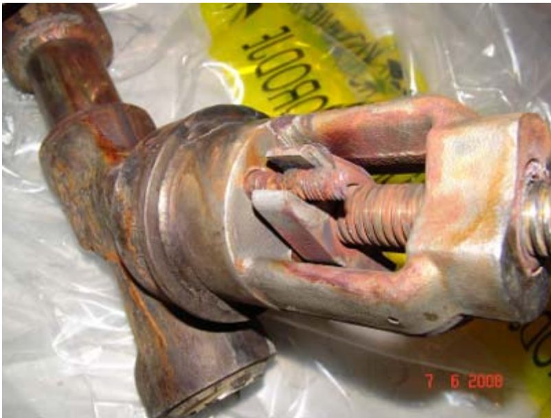
Slika 52: Poškodovani izolacijski ventil linije za meritev temperature primarnega sistema
