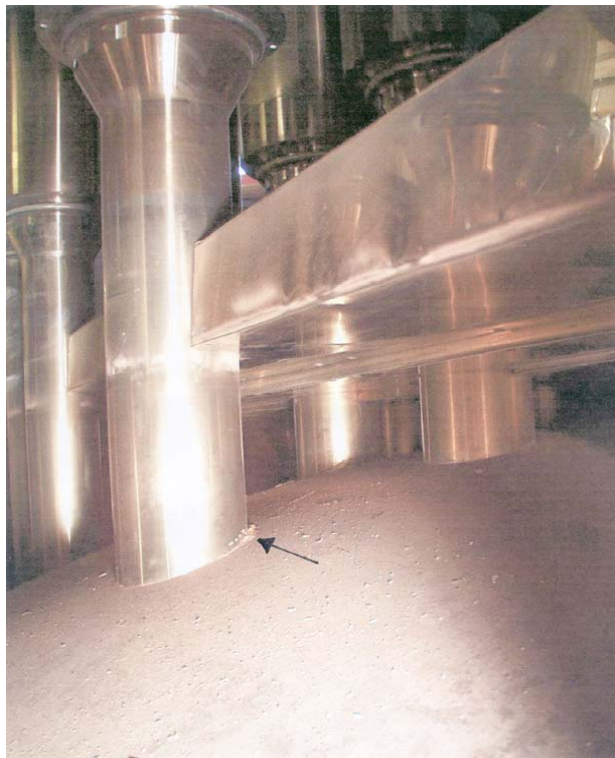
Slika 9: Obloge ob penetracijah reaktorske glave
