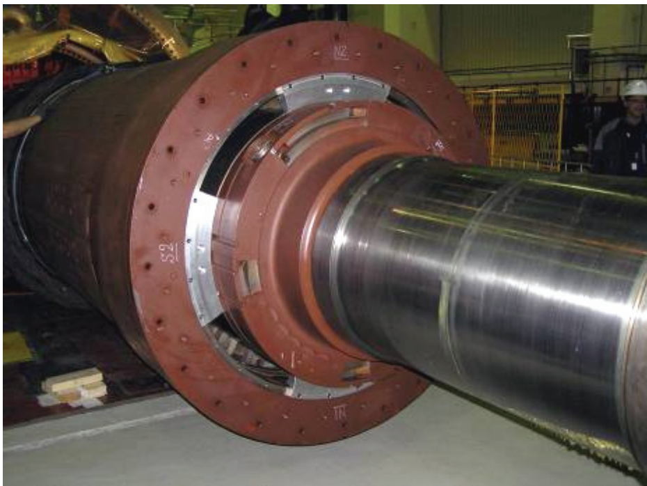
Slika 50: Montaža rotorja v novo ohišje glavnega generatorja
