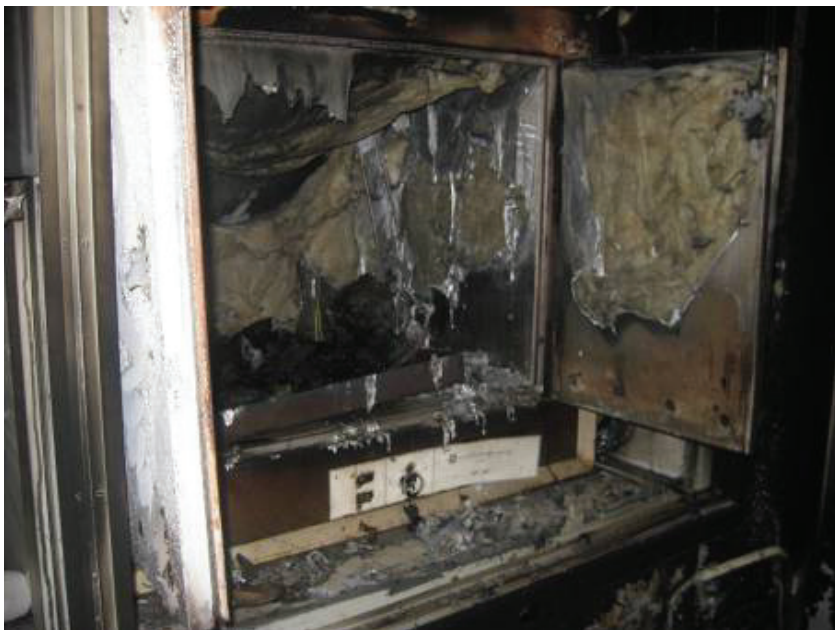
Slika 56: Zgorel sušilnik v digestoriju OVC
