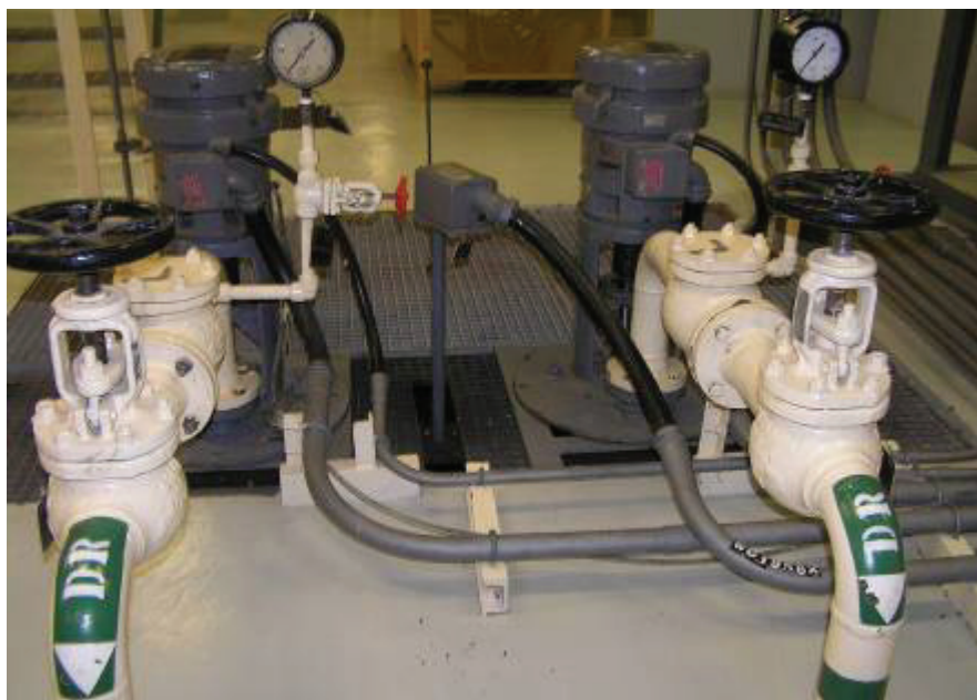
Slika 51: Zbiralnik s črpalkama v turbinski zgradbi
