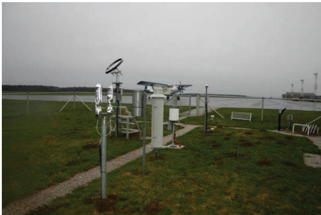
Slika 73: Merilno mesto na letališču Maribor (v ospredju sta sondi za merjenje hitrosti doze ionizirajočega sevanja, v ozadju je vidna meteorološka oprema)
