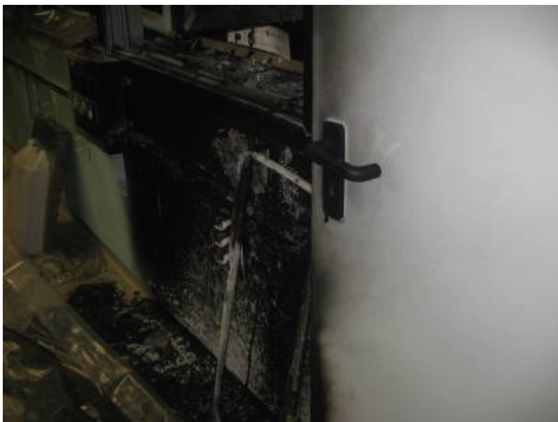
Slika 57: Kontaminirana tla in digestorij zaradi požara v digestoriju v OVC
