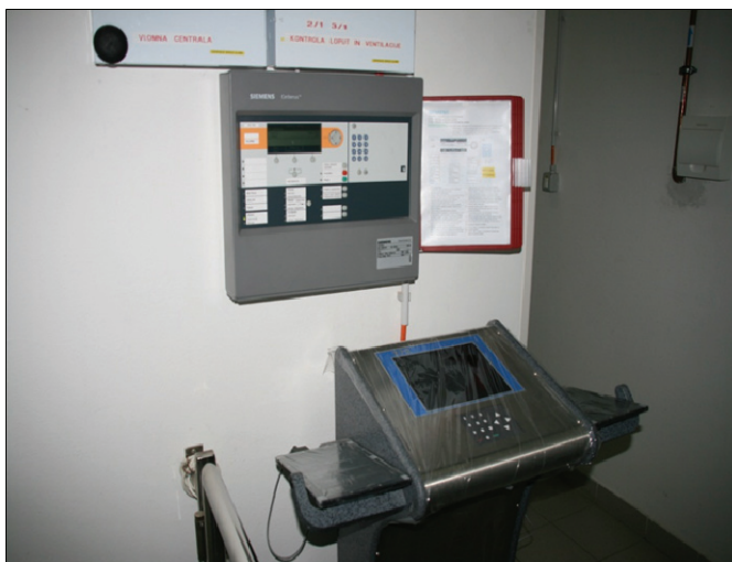
Slika 9: Nova neodvisna požarna centrala, nameščena v predprostoru skladišča
