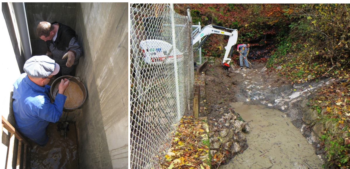
Slika 85: Čiščenje usedline na merilnem mestu ZDZ (levo) in čiščenje pregrade pod Podlešanom za zadrževanje sedimentov nad jarkom v odlagališča Jazbec (desno)
