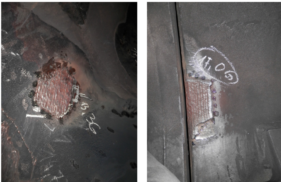
Slika 76: Sanacija degradiranih mest »cross-under« cevovoda
