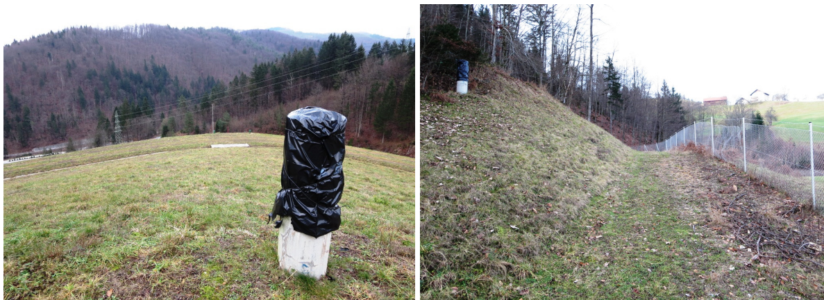
Slika 84: Lokacija stebra S6 na prelomu SV brežine odlagališča na zgornjo etažo odlagališča (levo), lokacija stebra S5 ob zahodnem robu odlagališča Jazbec (desno)
