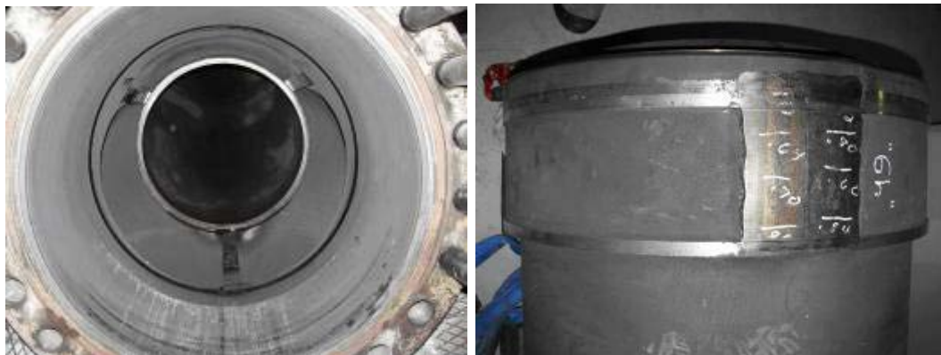
Slika 47: Pregled notranjosti izolacijskega ventila glavnega parovoda
