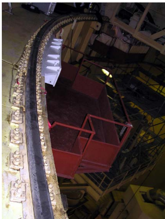
Slika 52: Posodobitev polarnega dvigala v zadrževalnem hramu med remontom 2009
