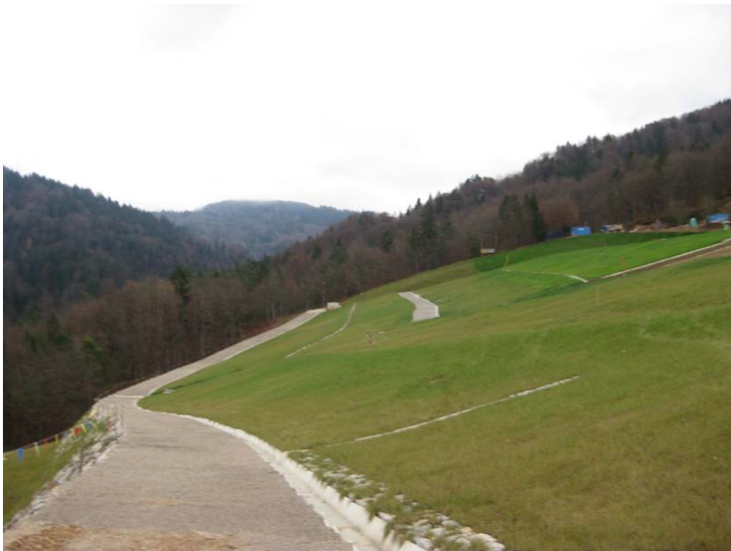
Slika 65: Na odlagališče Boršt so leta 2009 potekala zaključna dela, vidna je že urejena brežina in utrjen spodnji del odlagališča, t.i. »peta« (foto: Inšpekcija URSJV, 2009)
