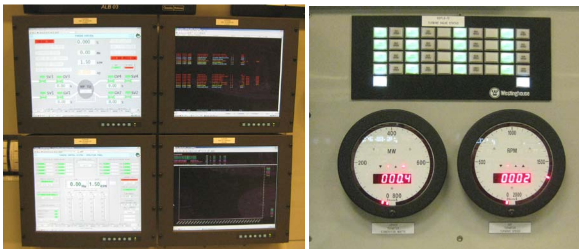
Slika 49: Sistem za digitalno regulacijo turbine – PDEH
