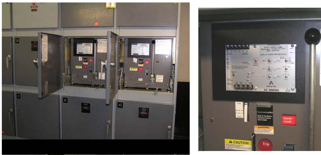
Slika 51: Odklopniki 125 V enosmerne napetosti v prostoru z možnostjo ostrega EQ okolje
