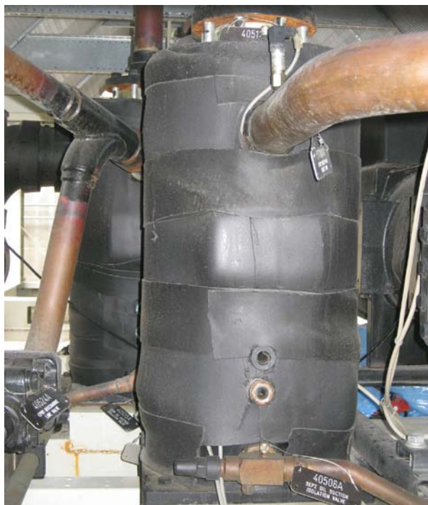
Slika 50: Dodatni električni grelniki na CZ enoti A in njihovo električno napajanje
