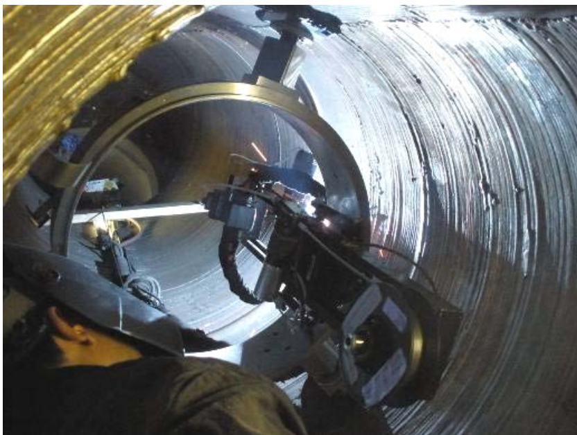
Slika 48: Navarjanje cross-under cevovoda med remontom 2009
