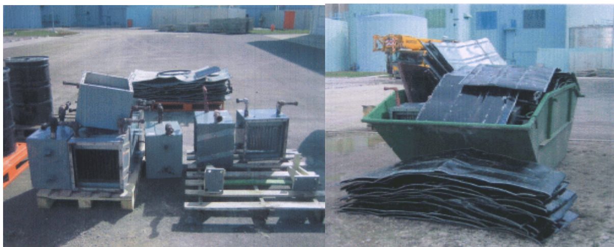
Slika 43: Demontirani deli grelno prezračevalne enote in razrezani kovinski sodi (vir: Poročilo o nadzornih meritvah, ki jih je opravil pooblaščen izvedenec za varstvo pred sevanji ZVD Zavod za varstvo pri delu, d. d.)
