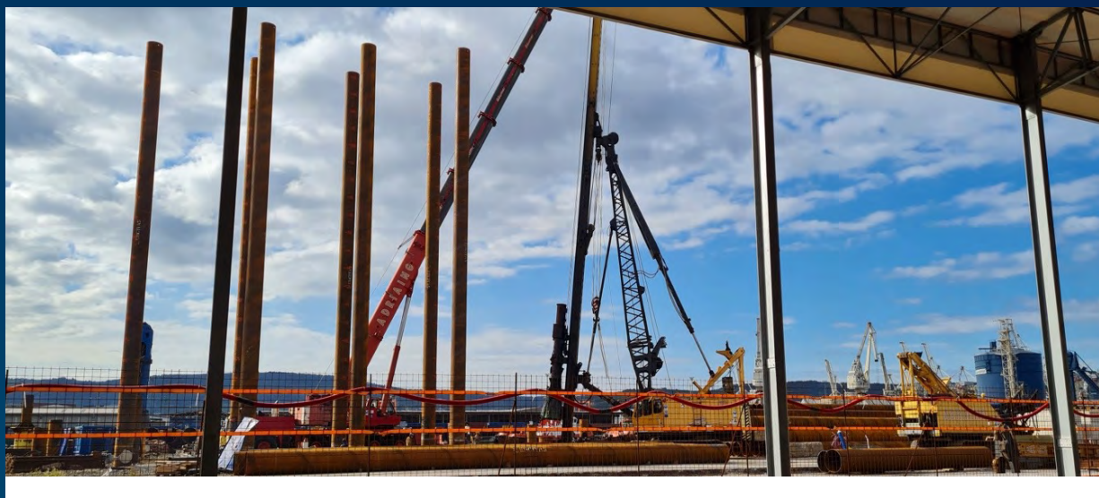
Slika 20: Gradbišče - 12. vez na II. Pomolu Luke Koper
