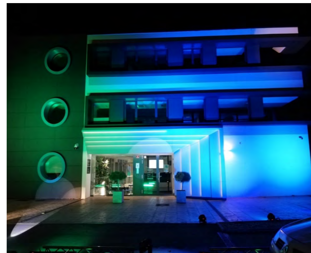
Slika 4: Poslovna stavba osvetljena v modro zeleno v počastitev svetovnega dneva pomorstva
