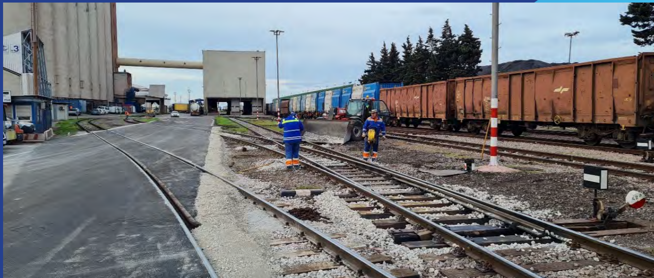
Slika 9: Izvajanje tekočega vzdrževanja železniške infrastrukture na tiru 47c
