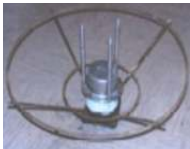
Glava strelovoda z jekleno-svinčnim vsebnikom, ki vsebuje vir sevanja ^{152/154}\text{Eu}
