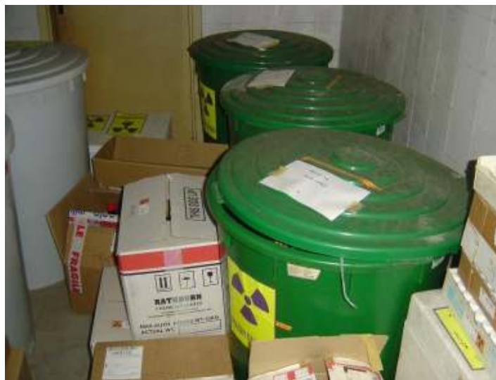
Primer neustreznega hranjenja radioaktivnih odpadkov, ki nastanejo pri delu z odprtimi viri sevanj
