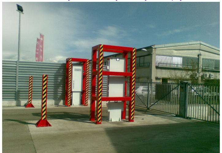
Portalni monitor na lokaciji zbiratelja odpadnih surovin v Ljubljani (Foto: arhiv URSJV, 2008)
