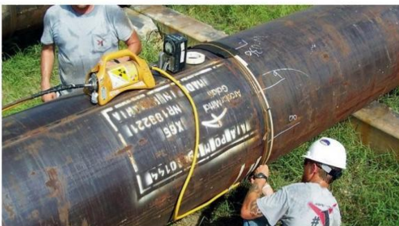
Kontrola zvarov na cevovodu
