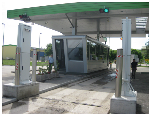
Portalni monitor na deponiji Barje. (Foto: Inšpekcija URSJV)
