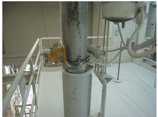
Vidne poškodbe na barvi vsebnika radioaktivnega merilnika spodnjega nivoja. (Foto: ZVD Zavod za varstvo pri delu d.d.)
