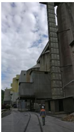
c | Silos klinkerja
