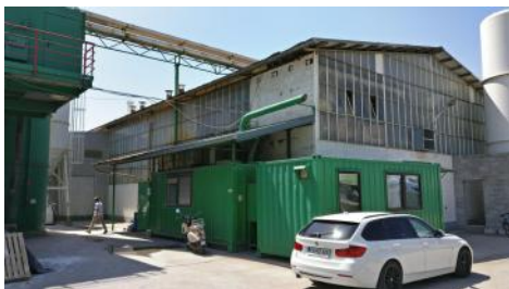
a | Proizvodna hala
