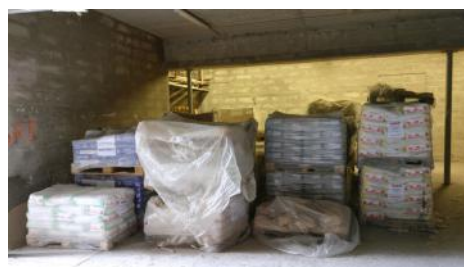
g | Skladišče betona za obzidavo peči
