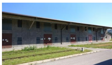
f | Skladišče nevarnih snovi
