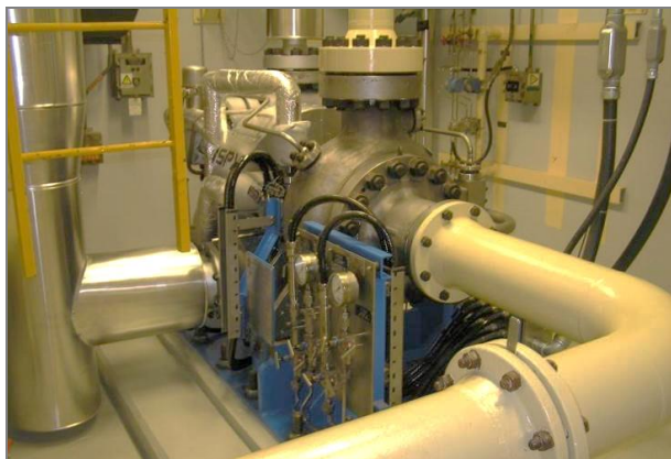
Slika 71: Nova turbinska črpalka pomožne napajalne vode (AFTD) (Foto: inšpekcija URSJV)
