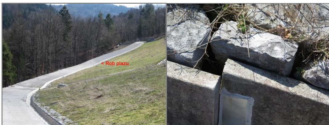
Slika 78: Severna skalometna peta, mesto prehoda preko roba plazu (levo), razmik kanelet in začasna zatesnitev prekritja kanelet – premik v enem letu (desno)
