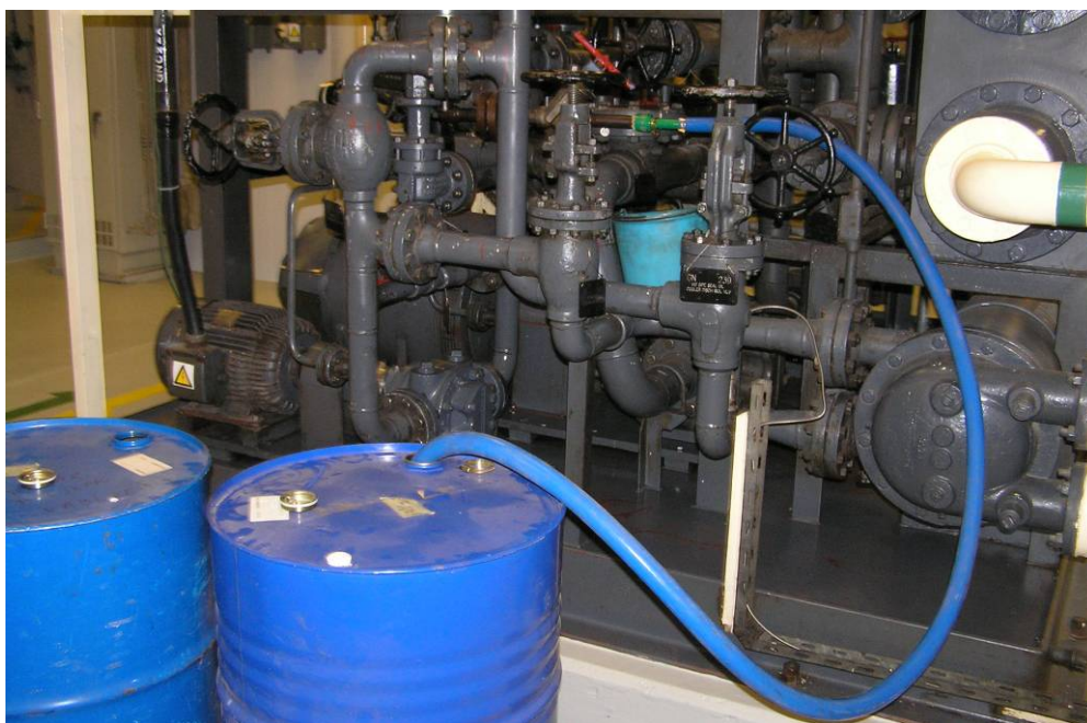
Slika 71: Dela na sistemu tesnilnega olja glavnega generatorja po zaustavitvi marca 2011
