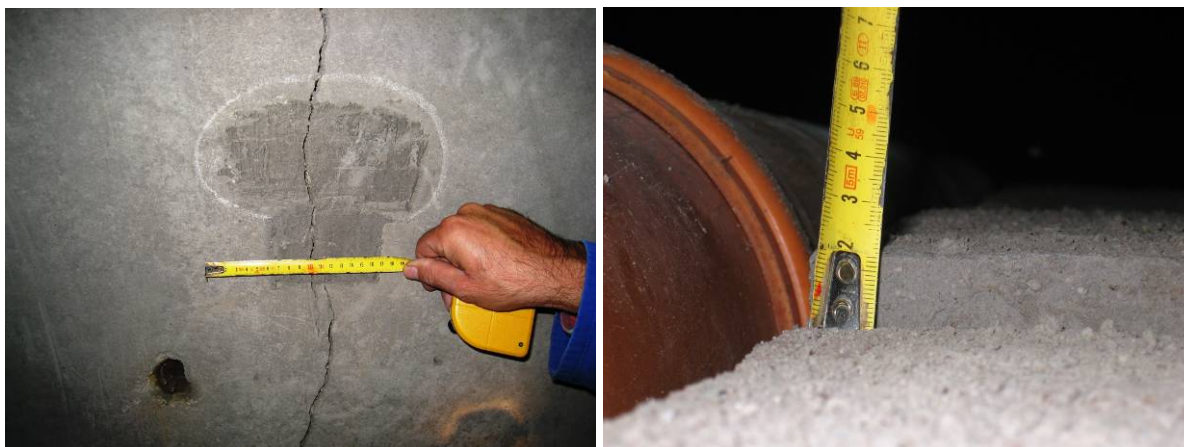
Slika 83: Poškodbe betona na saniranem prehodu drenažnega rova skozi plazino, levo razpoke na vertikalnem delu profila, desno dvig betonskih tal (stanje 9. 11. 2011)
