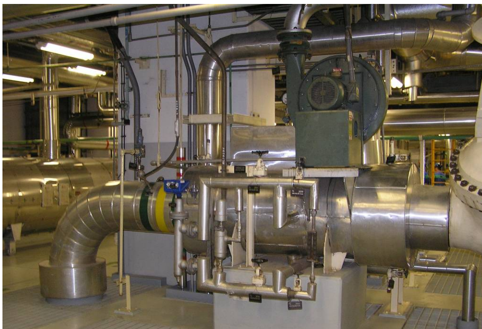
Slika 70: Kondenzator tesnilne pare turbine
