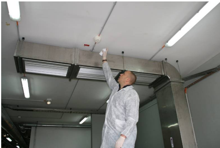
Slika 128: Funkcionalni preizkus delovanja javljalnikov požara v CSRAO
