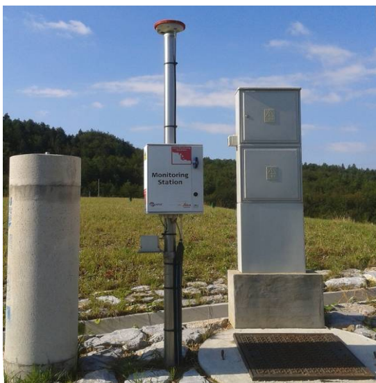
Slika 81: Opazovalna točka GPS nadzora stabilnosti območja odlagališča Boršt, lokacija GMX2 na zgornji etaži odlagališča
