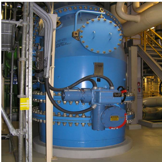
Slika 76: Vstopni CW cevovod v kondenzator
