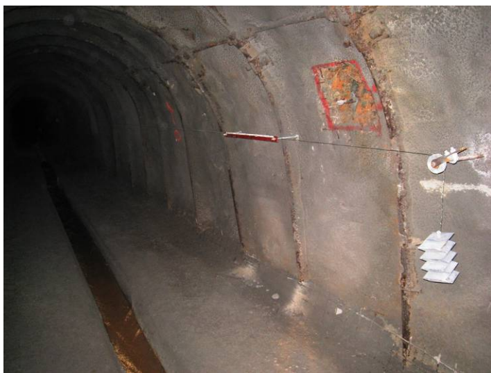
Slika 82: Lokacija ekstenziometra v drenažnem rovu, prehod rova skozi plazino (sanirani del je za ekstenziometrom)
