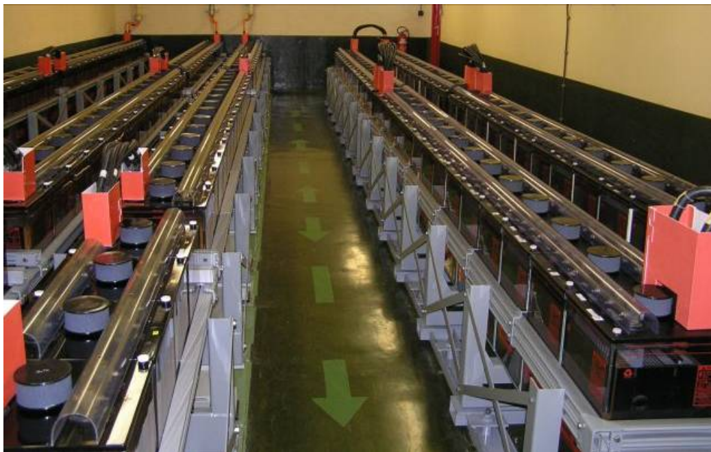
Slika 75: Novo vgrajena 125 V DC baterija
