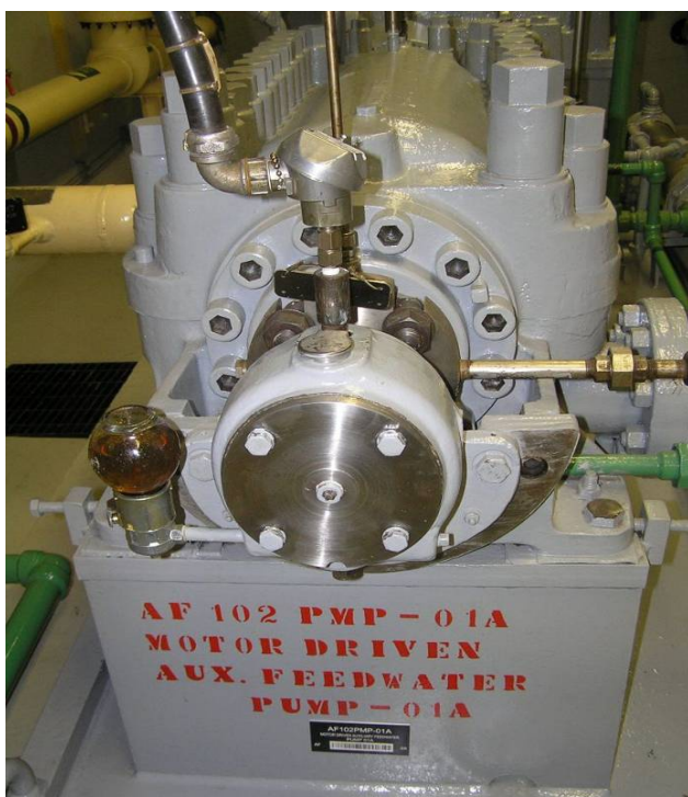
Slika 69: Motorna črpalka pomožne napajalne vode
