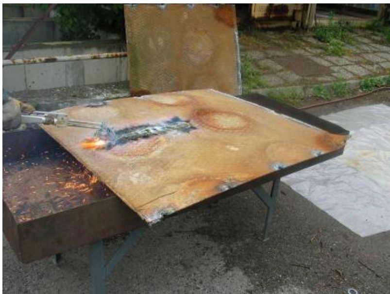
Slika 2.47: Razrez talnih plošč kontejnerja v nadzorovanem območju
