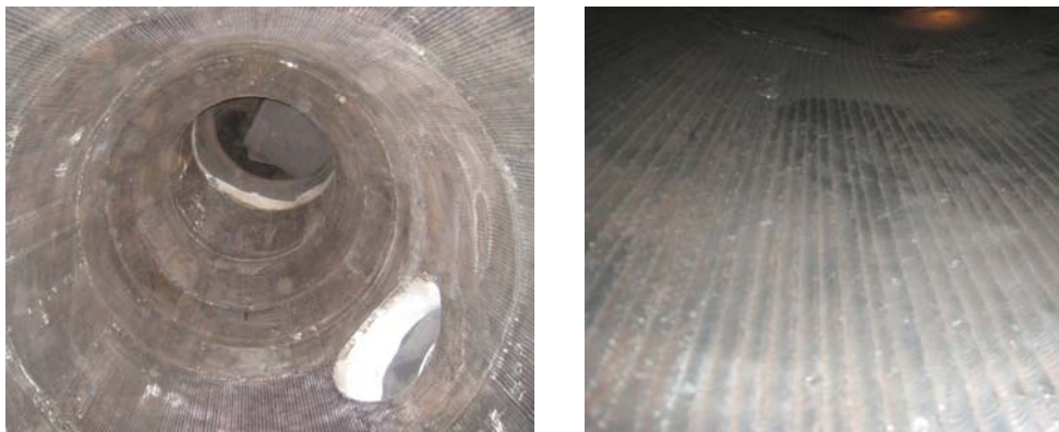
Slika 2.26: Sanacija notranjosti cevovoda med VT turbino in MSR
