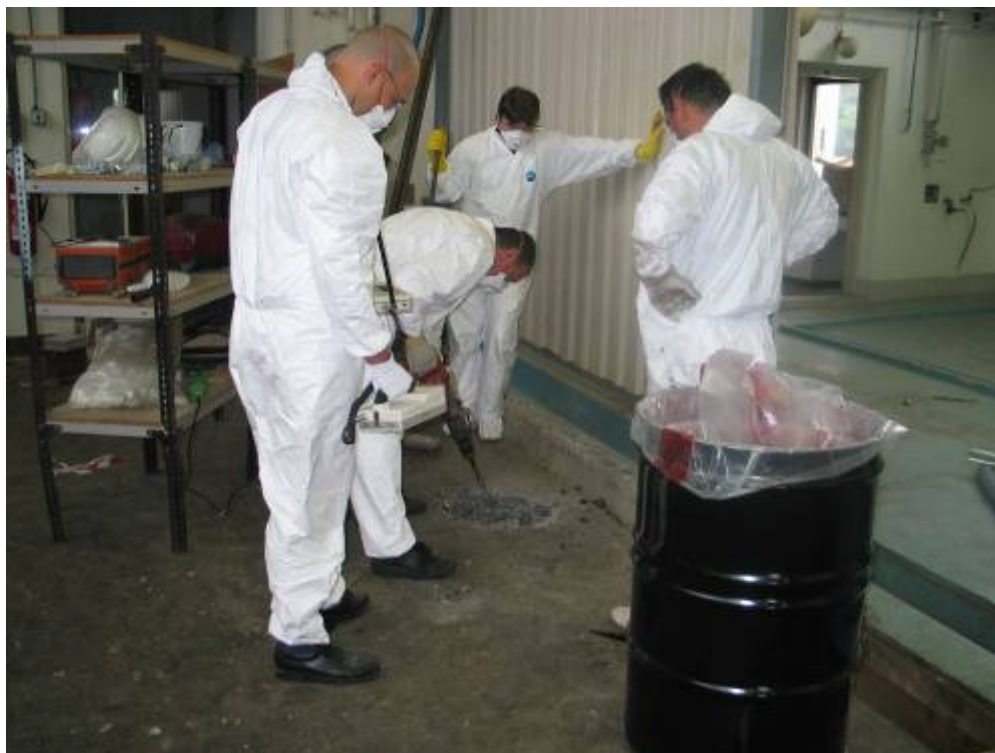
Slika 2.49: Odstranjevanje kontaminiranega dela tal
