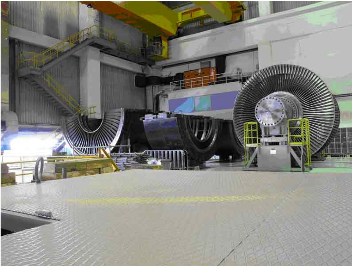
Slika 2.42: Zamenjava nizkotlačnih turbin
