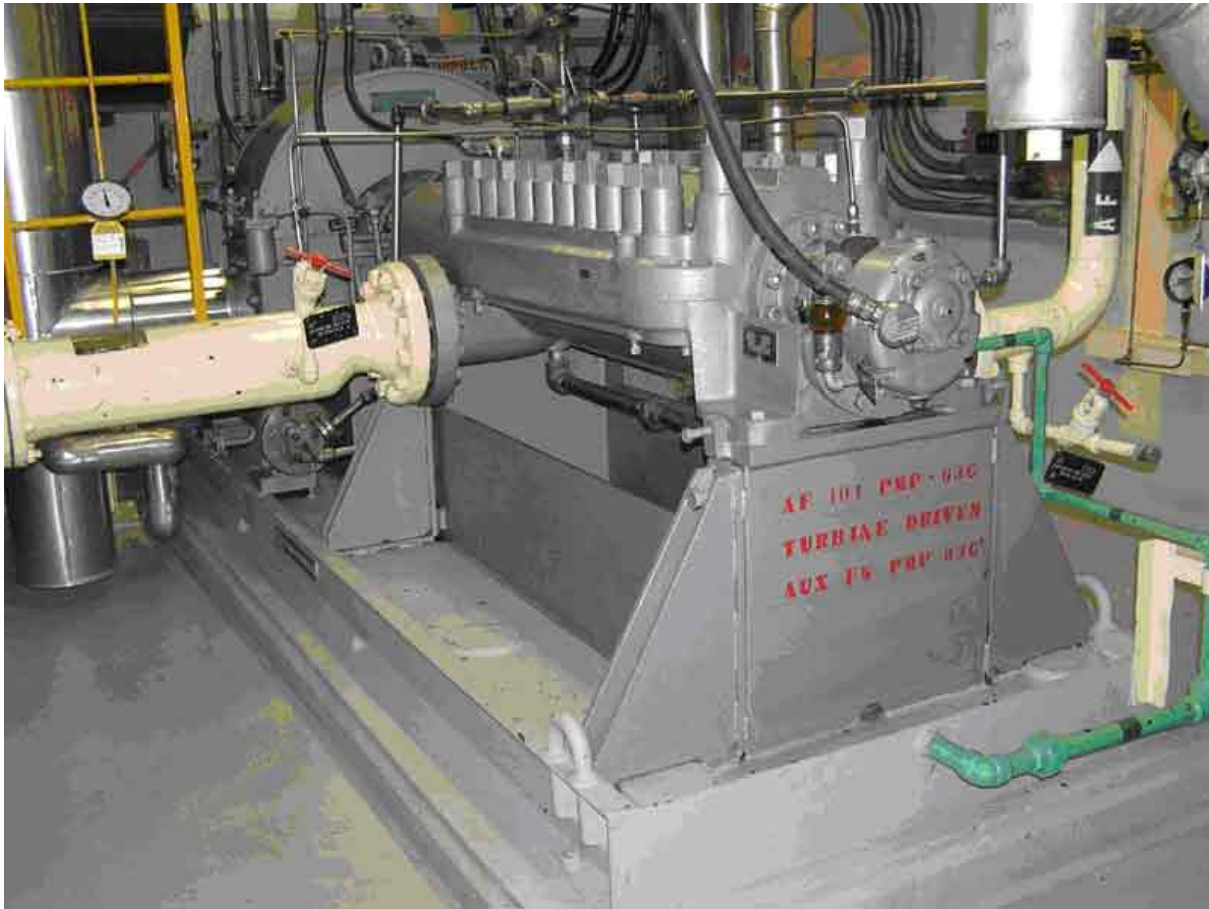
Slika 2.44: Turbinska črpalka pomožne napajalne vode
