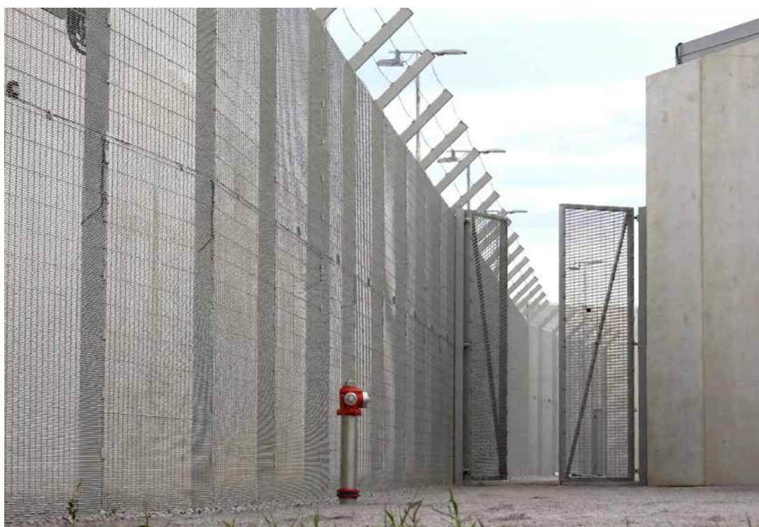
Zaprti del novogradnje ZPKZ Ljubljana
