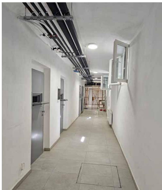
Obnova prostorov ZPKZ Ljubljana, Oddelek Novo mesto
