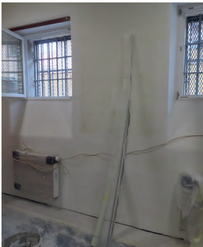
Potek obnove ZPKZ Ljubljana, Oddelka Novo mesto
