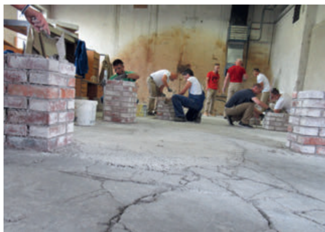
Usposabljanje za pridobitev NPK izvajalec del visokih gradenj v zavodu Dob
