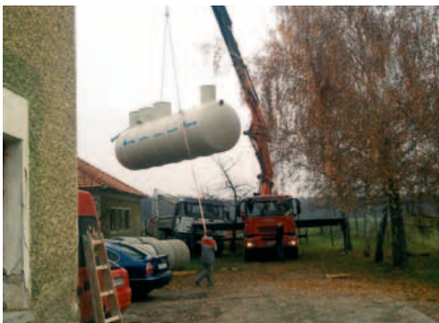
Montaža nove čistilne naprave v odprtem oddelku Rogoza
