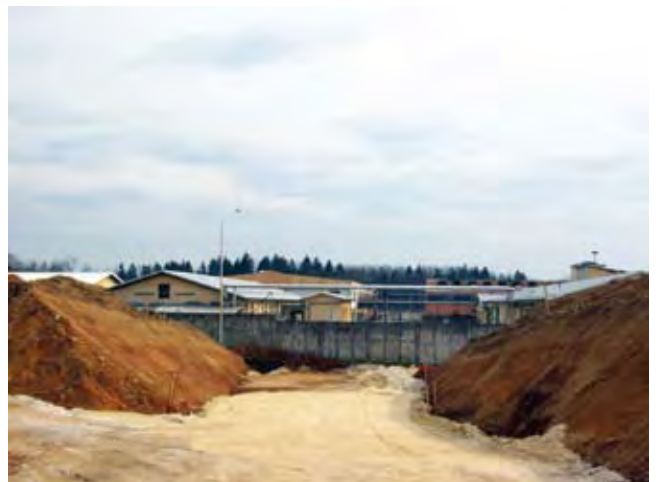
Obnova zapora Dob: gradbena dela
