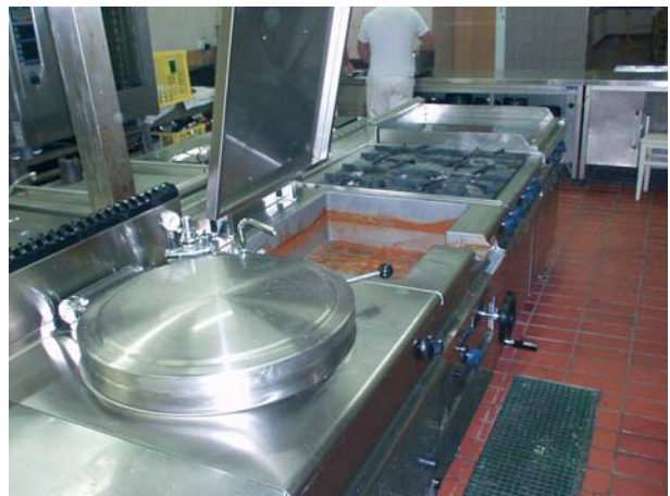
Delno obnovljena kuhinja
