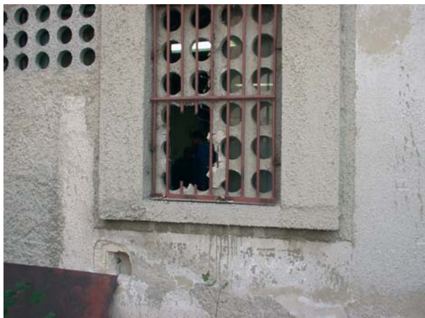
Pobeg iz delavnice v zavodu Ljubljana
