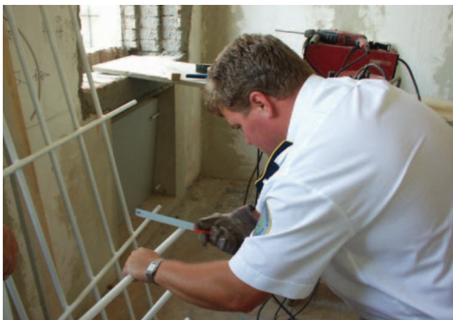
Preverjanje kakovosti posebnega železa za rešetke za obnovljeni del pripora v Mariboru
