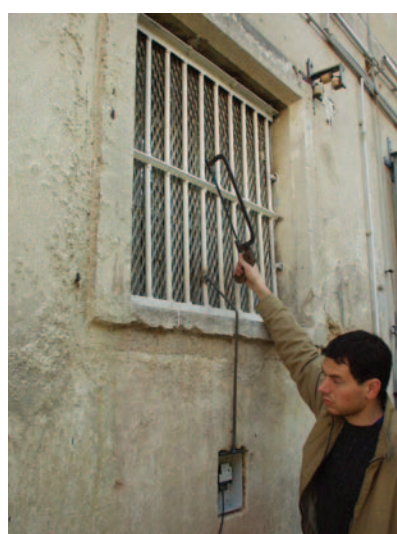
Testiranje signalizacije rezanja okenskih rešetak
