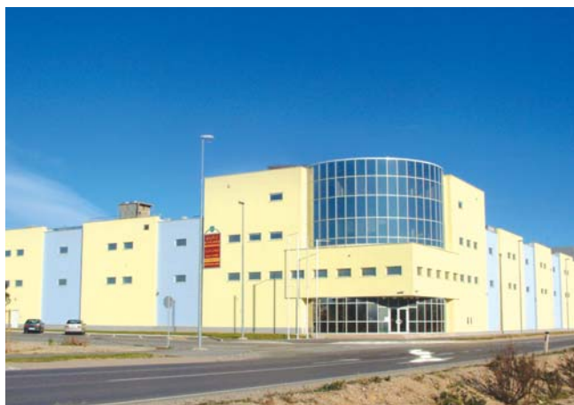
Zaključek gradnje novega zavoda Koper
