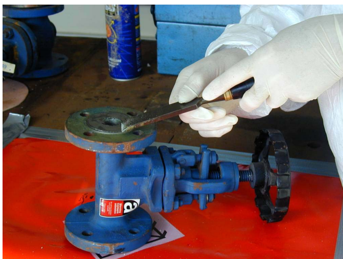
Slika 11.5 Uporaba ročnega orodja samo za čiščenje in odstranjevanje azbestnega tesnila z ventila.
