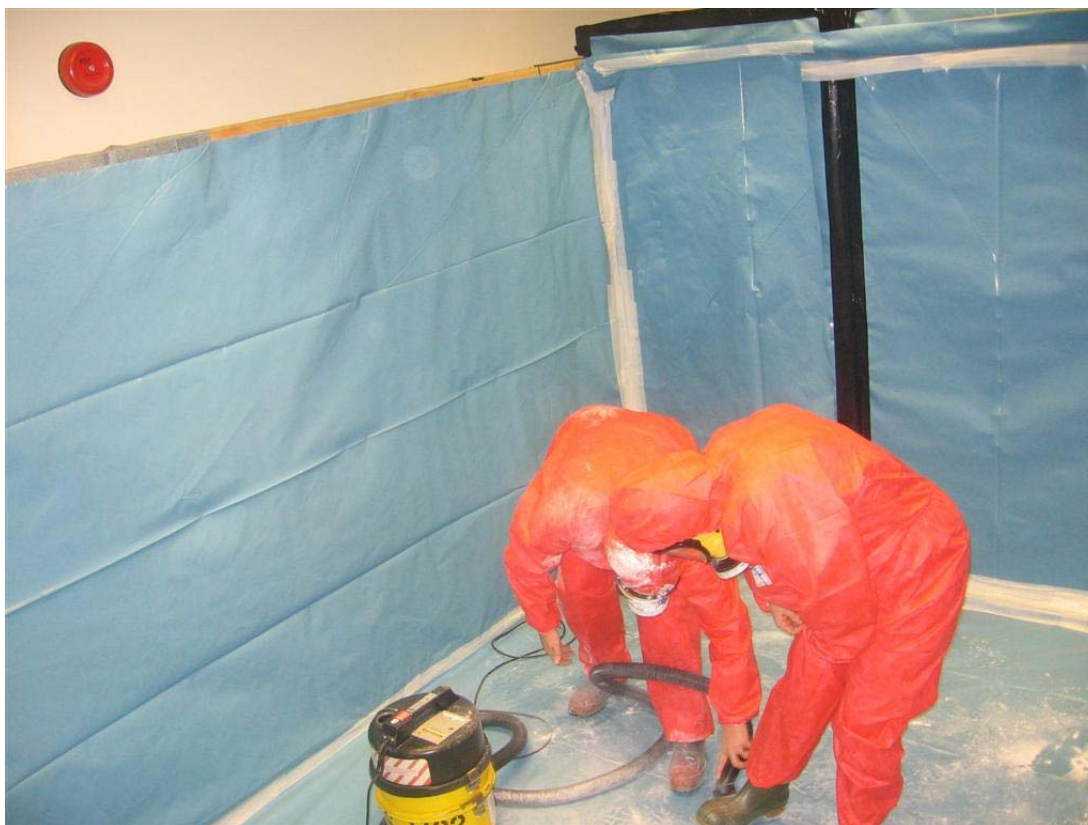
Slika 7.1 Praktično usposabljanje za uporabo sesalnikov vrste H pri odstranjevanju simulirane kontaminacije (smukec).Sliko dal na voljo Izvršilni organ za varnost in zdravje pri delu Združenega Kraljestva.
