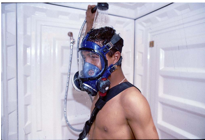
Slika 12.5 Dekontaminacija s sesalnikom vrste H, pod prho v vodotesni zaščitni delovni obleki s kapuco in prhanje pred odstranitvijo opreme za zaščito dihal. Fotografije dal na voljo (fotografije zagotovil INRS; avtorske pravice INRS).
