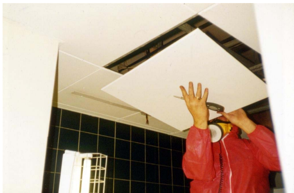
Slika 12.13 Previdno odstranjevanje azbestne plošče.
