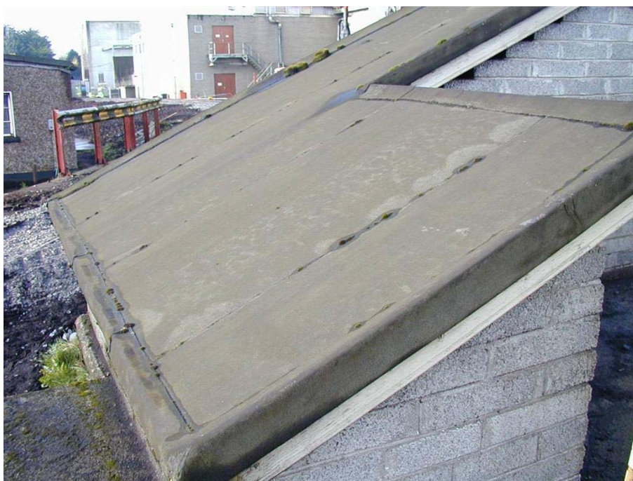
Slika 4.7 Azbestna strešna izolacija.
