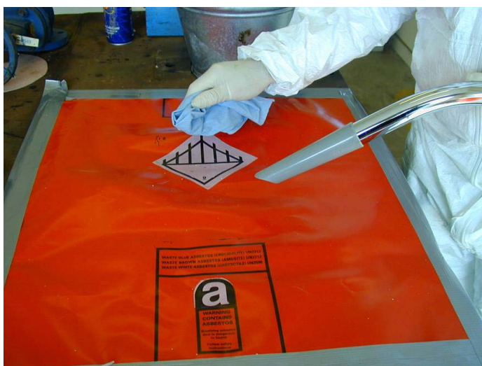
Slika 11.7 Previdno čiščenje delovne površine s sesalnikom vrste H in mokrimi krpami za enkratno uporabo.
